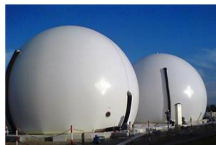
全天候型・メンテナンスフリー。エアプロアーにより安定した圧の供給と超音波センサーにより内部ガスの貯留量を管理しています。タンク上部にとりつけば、タンクを発酵槽として利用できます。シングルタイプも供給可能です。
